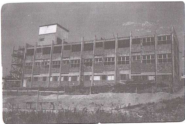
São Bernardo do Campo. Sede do Nosso Lar, em construção.
